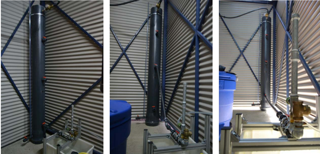
Figura 8-1 – Bomba de ariete instalada con 3 configuraciones diferentes de la tubería de alimentación.
