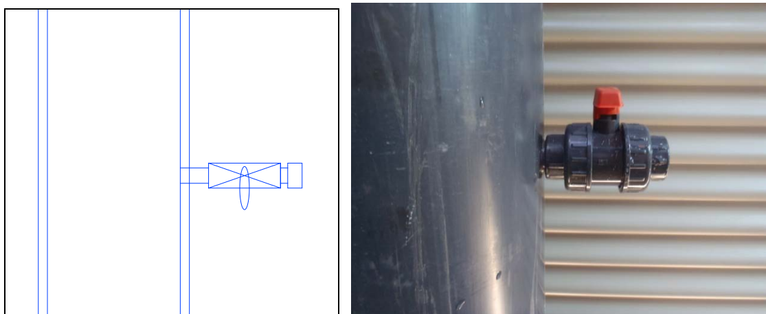
Figura 4-7 – Uno de los taladros intermedios, posible salida hacia la bomba de ariete.
