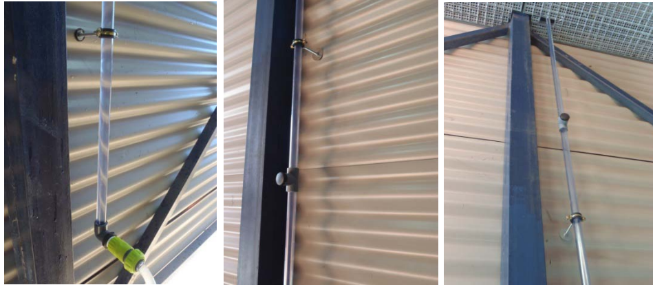
Figura 4-15 – Tubería de elevación, de 7 metros de longitud, fijada a la pared del laboratorio.
