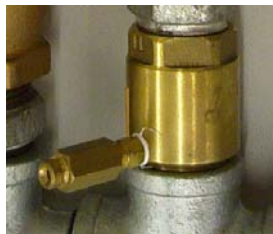
Figura 2-20 - Válvula de purga de aire acoplada a la válvula de NR
