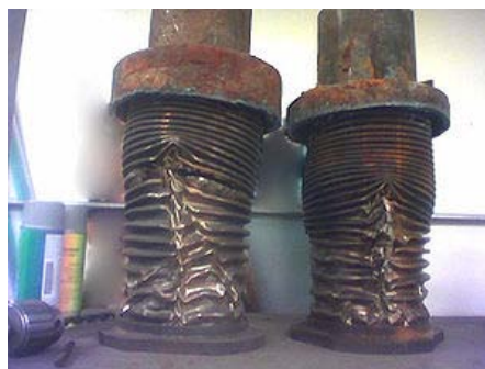
Figura 2-6. Tuberías estropeadas por la depresión provocada por el golpe de ariete. Fuente: http://es.wikipedia.org
