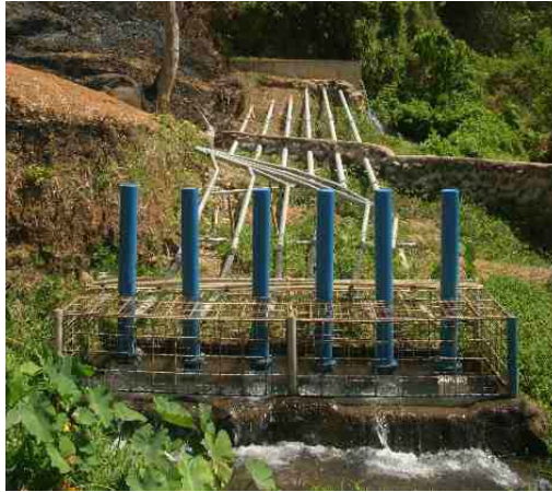
Figura 2-21 – Instalación de 6 bombas de ariete conectadas en paralelo. Fuente: www.chinadalogue.net
