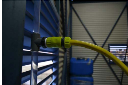
Figura 4-19 – Circuito de recogida acoplado a una de las salidas elevadas de la tubería de elevación
