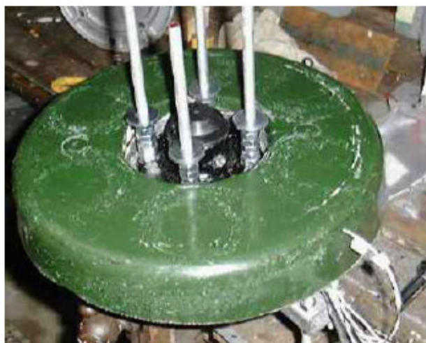
Montaggio dello statore
