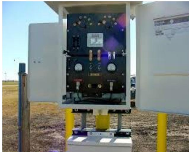
fig.4n : Generatore di corrente per la protezione catodica.
