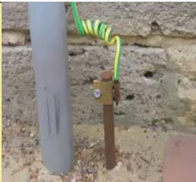
fig.3n : Collegamento di un dispersore.
