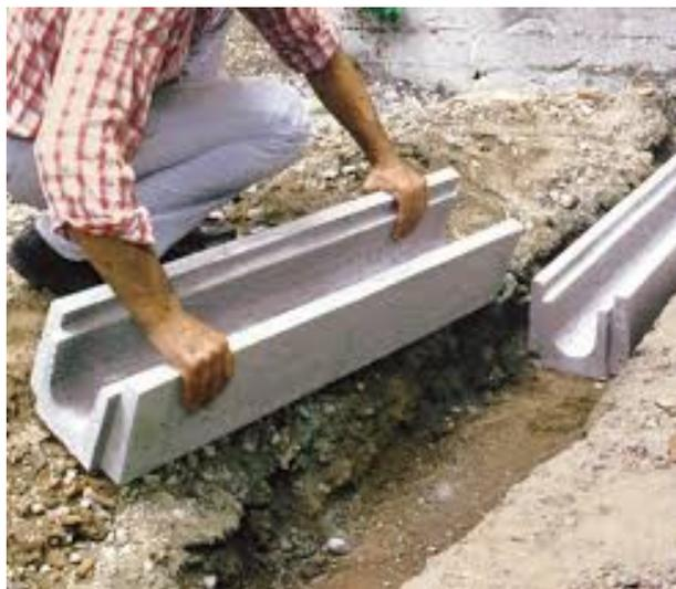
fig.4z : Messa in sede di una canalina.
