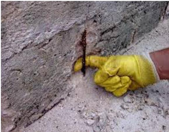
fig.3p : Corrosione di un ferro d'armatura delle strutture in calcestruzzo armato.
