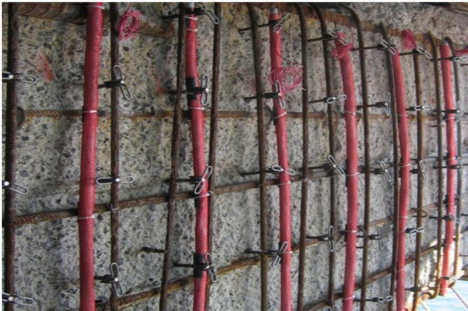
fig.4k : Collegamenti per la protezione a corrente impressa in un armatura nel calcestruzzo.
