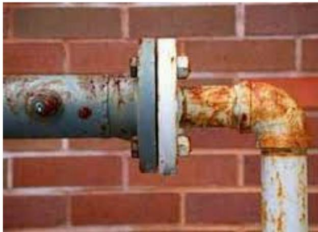
fig.5b : Corrosione nelle tubature esterne.
