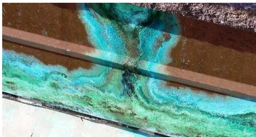
fig.2b : Corrosione alcalina di una lastra di rame.
