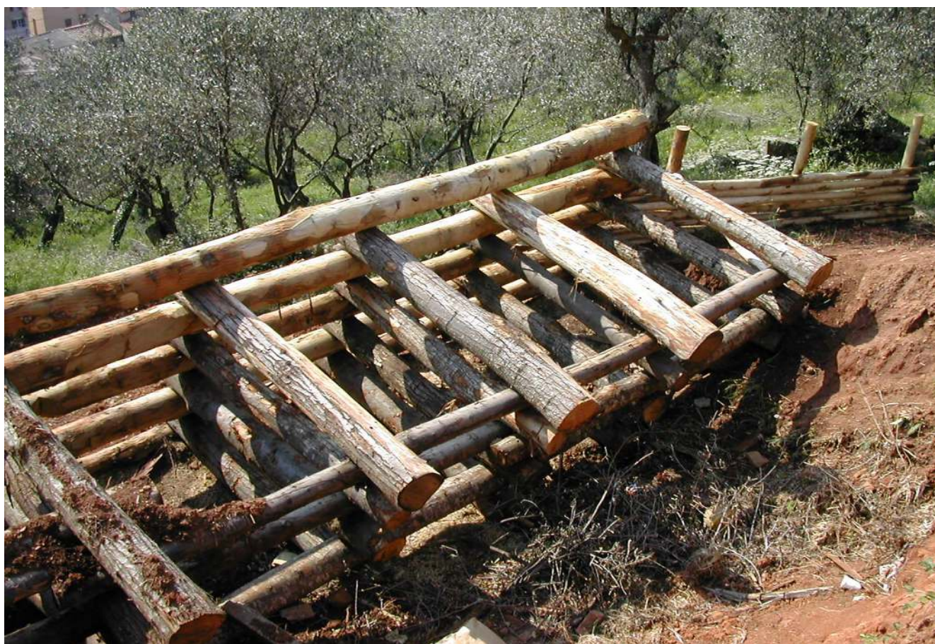
INTELAIATURA DELLA PALIFICATA
