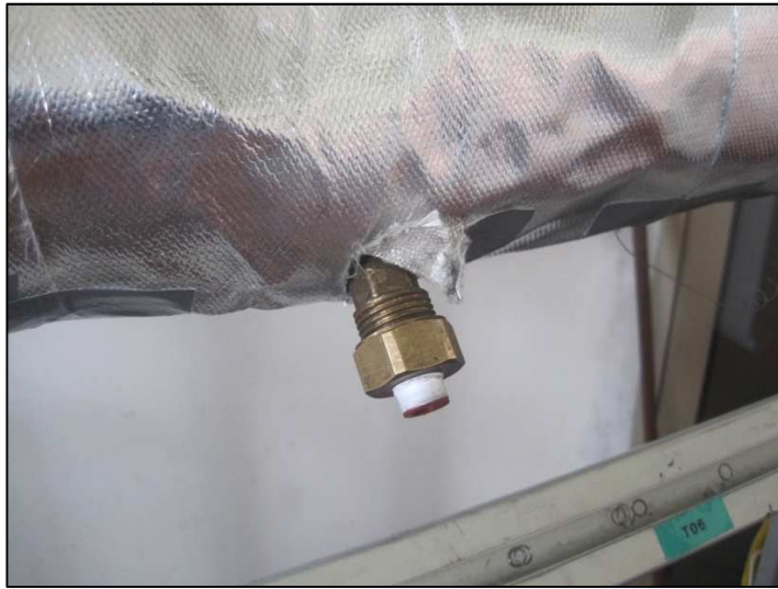
Fig. 3.4: Dado di innesto sul collettore
