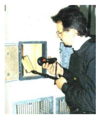
Occorre assicurarsi della tenuta della camera di combustione
