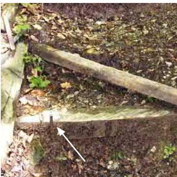
Fig. 86 Ferro di armatura sporgente
