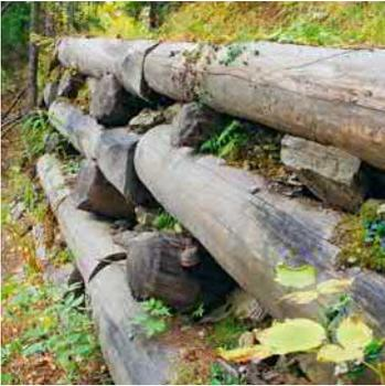
Fig. 79 Palificata di sostegno
