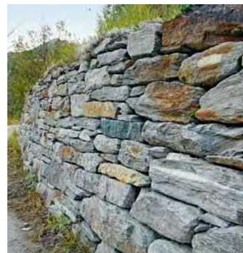
Fig. 82 Muro a secco
